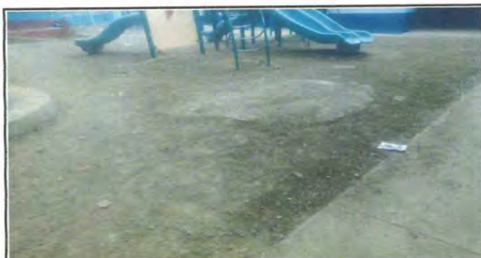
Foto 4: ENTORTADO PATIO CON CERNIDO 10CM DE GROSOR 217 M2
