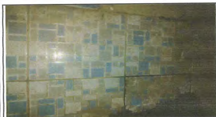
Foto 3: COLOCACION DE PISO CERÁMICO, COLOCACION DE AZULEJO, PINTURA BAÑOS (DOCENTES Y NIÑOS)
